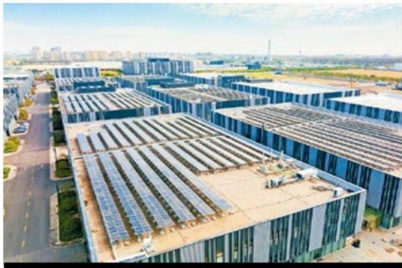
Met zonnepanelen op bedrijfsdaken valt nog veel duurzame winst te boeken.
